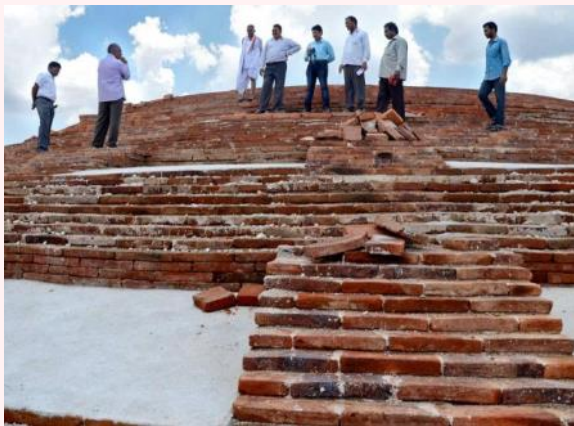
Các quan chức Cục Khảo cổ tại Đại Bảo tháp đang được tu sửa Photo: G.N. Rao
